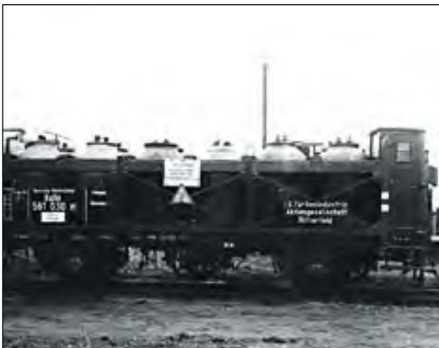
Der Säuretopfwagen Halle 561 030 P der IG Farben wurde Ende der 1920er Jahren von Kaminski repariert. Möglicherweise gibt es hier einen Zusammenhang zum Patent, das die Firma 1929 für einen „Sicherheitstopf mit Flüssigkeitsverschluss“ erhielt (Franz Kaminski Waggonbau GmbH)
